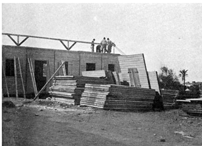
Stavba Döckerových domků v roce 1909 po zemětřesení v jižní Itálii. Sloužili jako nouzové ubytovny
