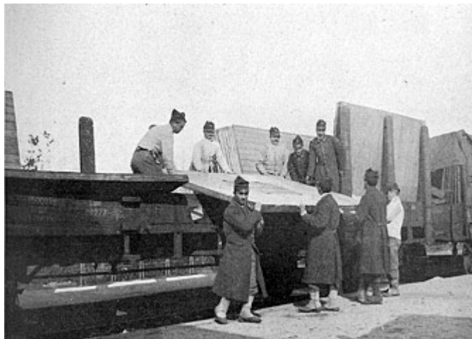
Vykládka panelů dřevostaveb systému Döcker
